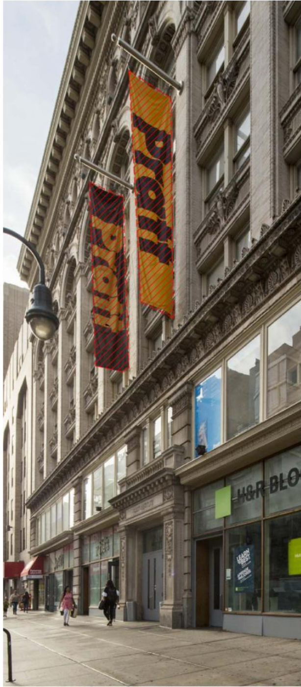
1 EXISTING SIGNAGE PHOTO N.T.S.
