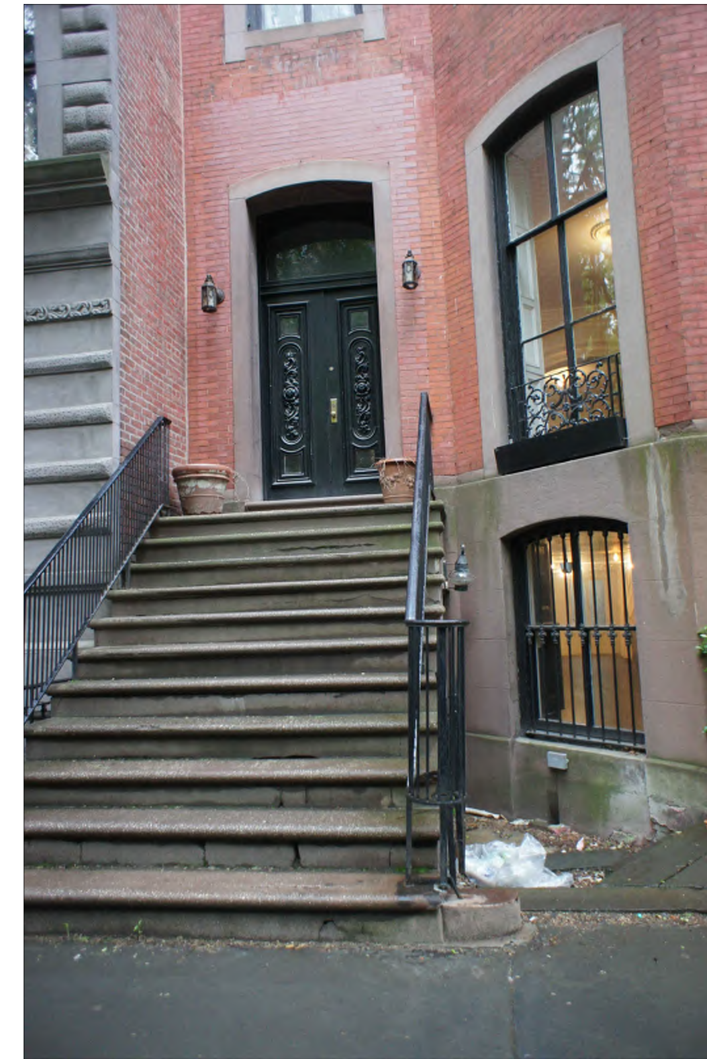
EXISTING STOOP & ENTRY DOOR
